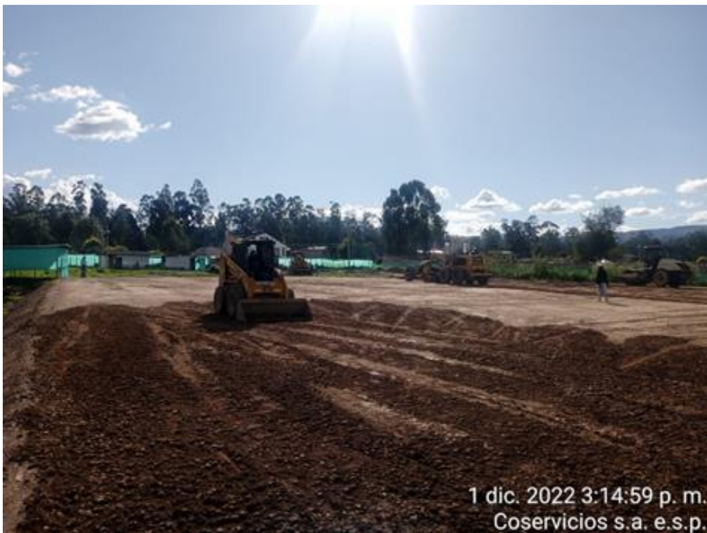
Conformación de terraplén
