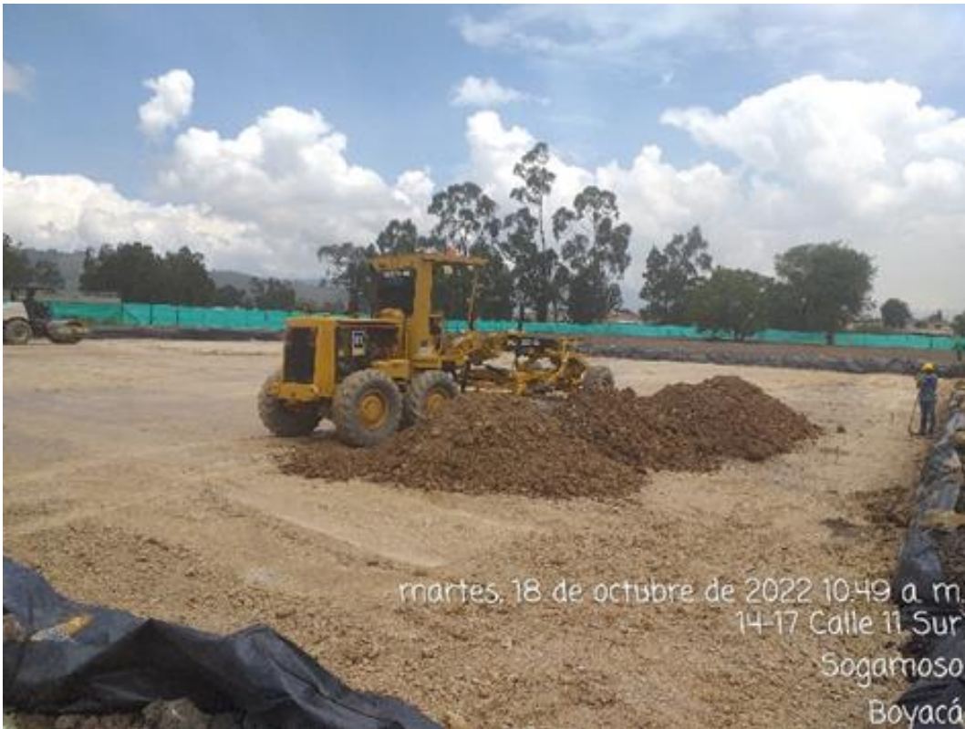
Instalación de mejoramiento (recebo)
