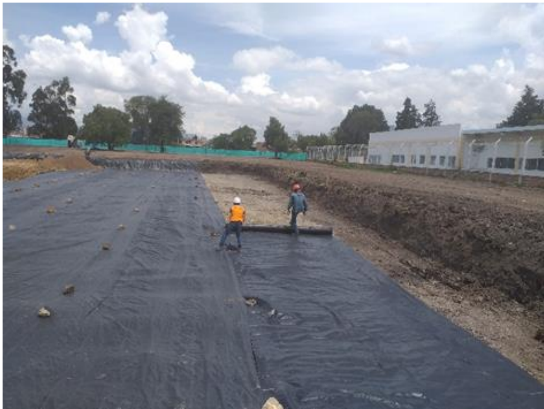
Instalación de geotextil sintético
